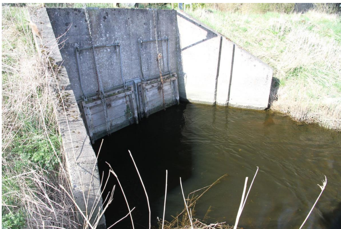
Foto 3. Den nemt passable sidehængslede højvandssluse i Gundslev Å øverst og den svært passable tophængslede sluse i Søborg Kanal.
