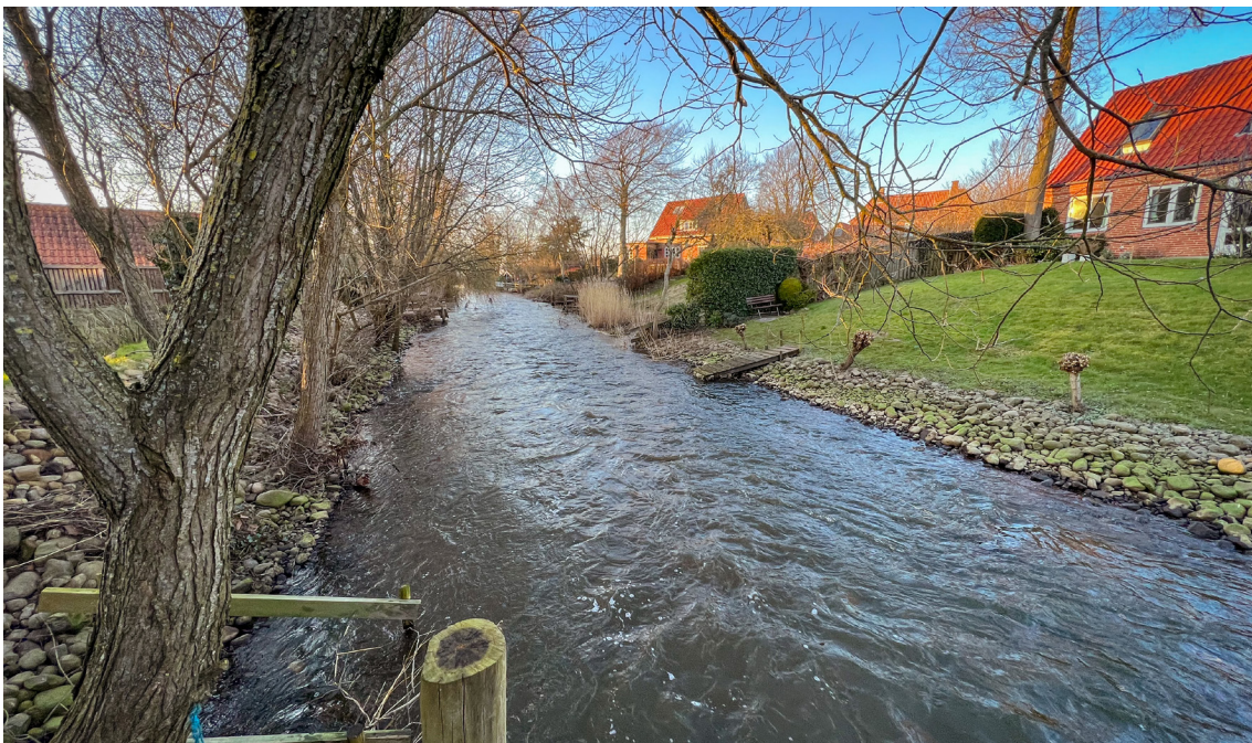
Stampemølleåen kan ikke modtage mere vand pga. risiko for oversvømmelse af ejendomme langs vandløbet. Vandløbet modtager yderligere vandmængder via det lille tilløb Haulund bæk
